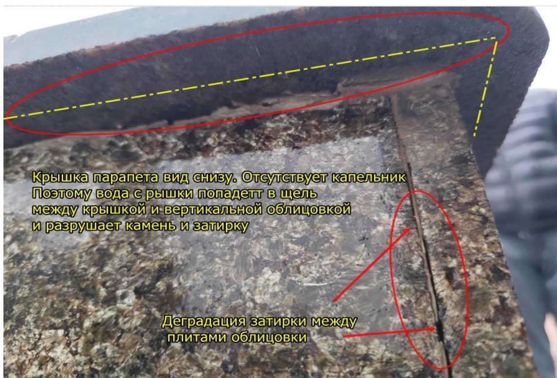
Фото 9 Крышка парапета. Отсутствие капельника, деградация затирки между вертикальными плитами облицовки
