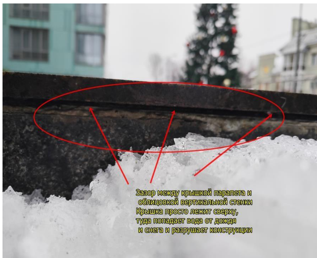
Фото 7 Отслоение облицовки гранита наружных стен паркинга в результате протечек
