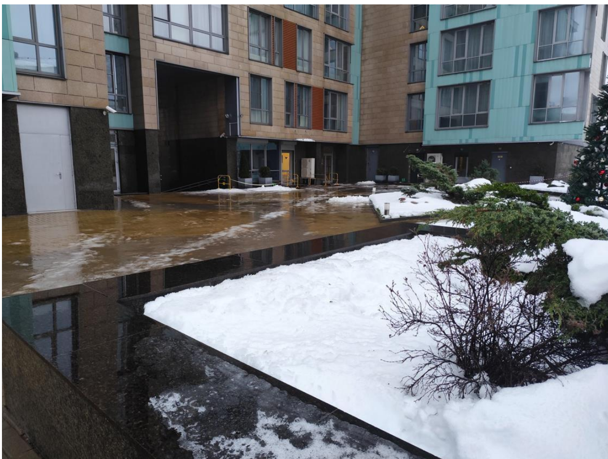
Фото 3 Внешний вид эксплуатируемой кровли паркинга
