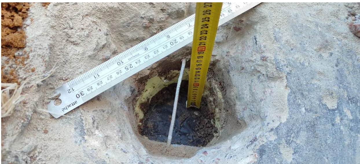
Фото 10, 11, 12. Фотофиксация при откопке шурфа
