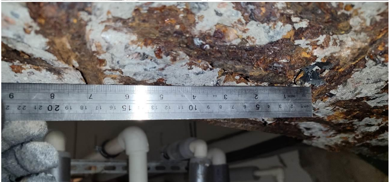
Фото 5-8. Фотофиксация замеров армирования ригеля в осях Д//7-8
