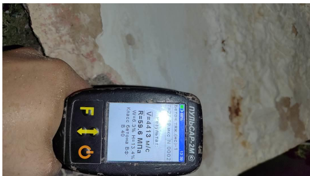
Фото 1-2. Фотофиксация испытания прочности бетона ультразвуковым методом
