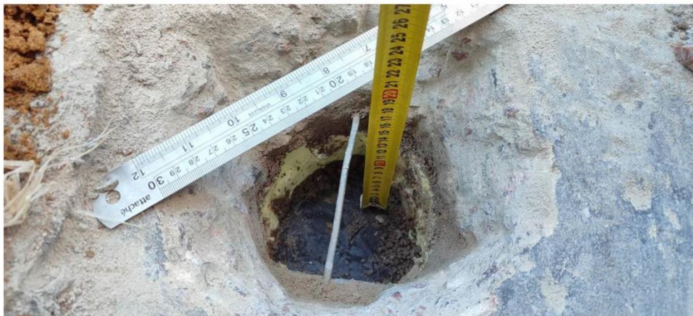
Фото 10, 11, 12. Фотофиксация при откопке шурфа
