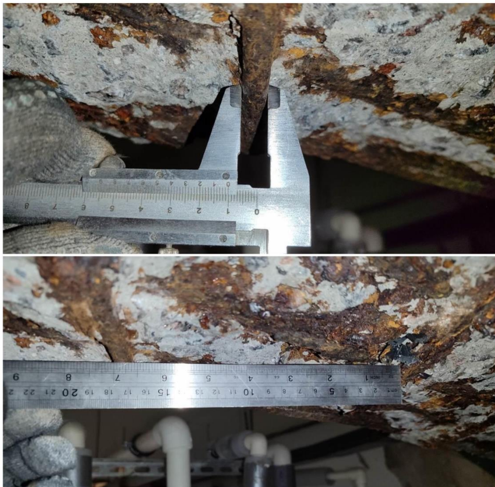
Фото 5-8. Фотофиксация замеров армирования ригеля в осях Д/7-8
