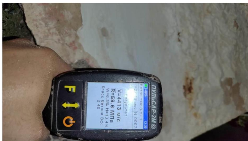
Фото 1-2. Фотофиксация испытания прочности бетона ультразвуковым методом
